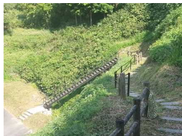
展望台階段、手摺の補修 (吉賀町 大井谷)
