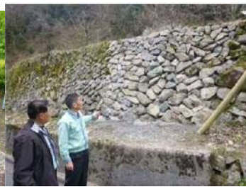
棚田石垣の補修 石積み手順書の作成 (吉賀町 大井谷)
