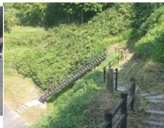
展望台階段、手摺の補修 (吉賀町 大井谷)
