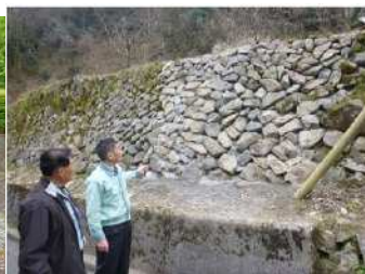
棚田石垣の補修 石積み手順書の作成 (吉賀町 大井谷)
